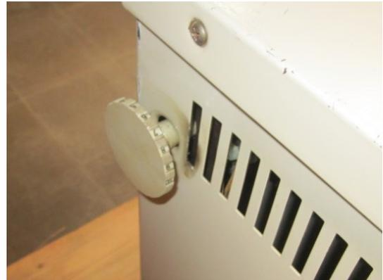
Abbildung 2. Alte Elektrospeicherheizung (links) und Detail des Einstellrads am Heizkörper (rechts).
